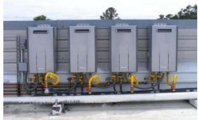
Calentadores de condensación instalados en serie en exterior
