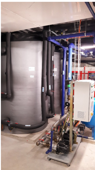
Imágenes de la instalación, depósitos de inercia, kit solares y ACS central y sistema de bombeo y reparto para suelo radiante.
