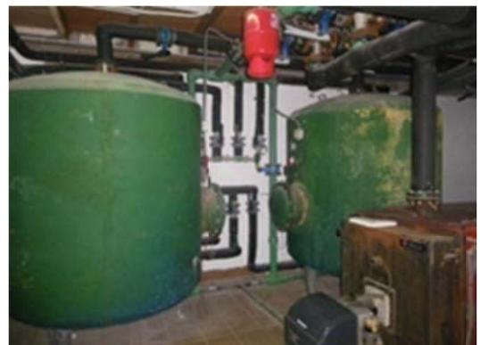
**Cambio de combustible y reposición del sistema de producción de A.C.S por un sistema semi-instantáneo de condensación – eficiencia y ahorros energéticos asociados.**
