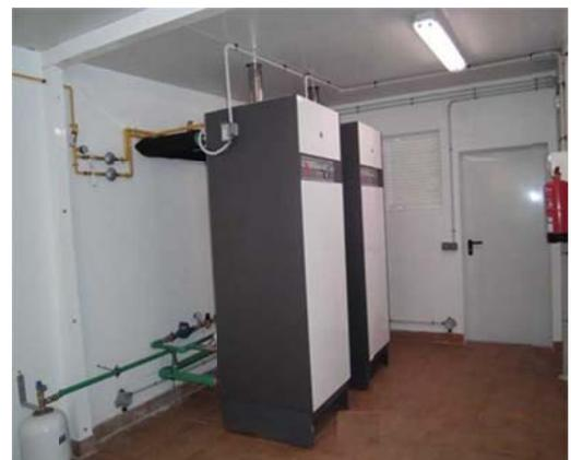
Cambio de combustible y reposición del sistema de producción de A.C.S por un sistema semi-instantáneo de condensación – eficiencia y ahorros energéticos asociados.
