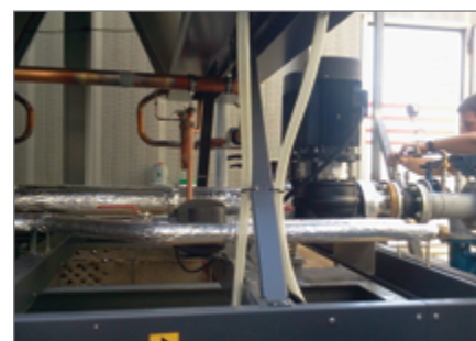
Hotel Capri: Trabajos durante la instalación
