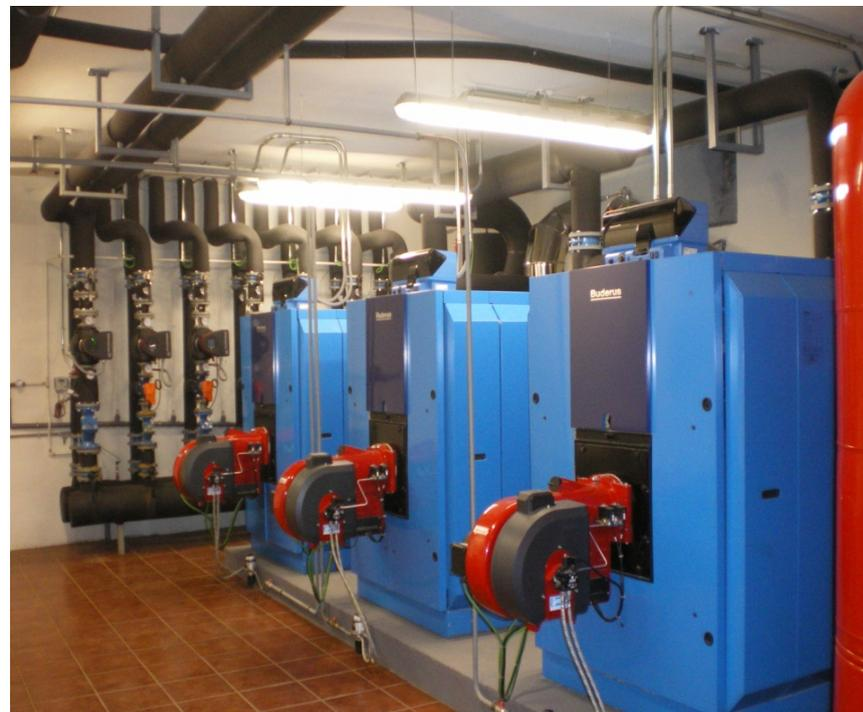
Calderas de gas o gasóleo de condensación, con alta eficiencia energética y funcionamiento silencioso, y de alta fiabilidad operacional.
