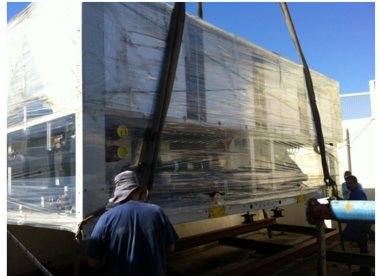
Sustitución de la antigua enfriadora por la nueva de alta eficiencia
