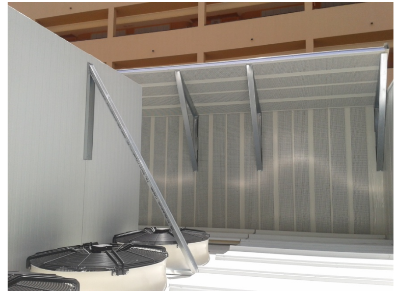
Enfriadora de alta eficiencia con recuperación de calor y detalle de insonorización acústica
