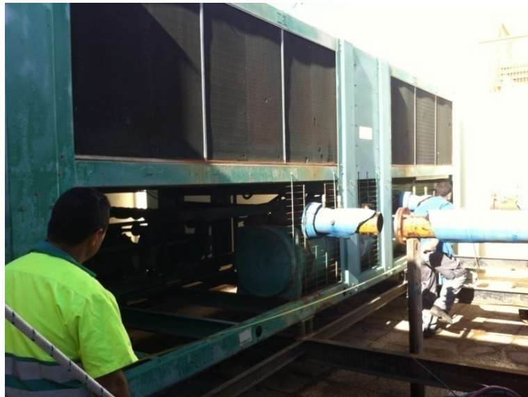
Sustitución de la antigua enfriadora por la nueva de alta eficiencia
