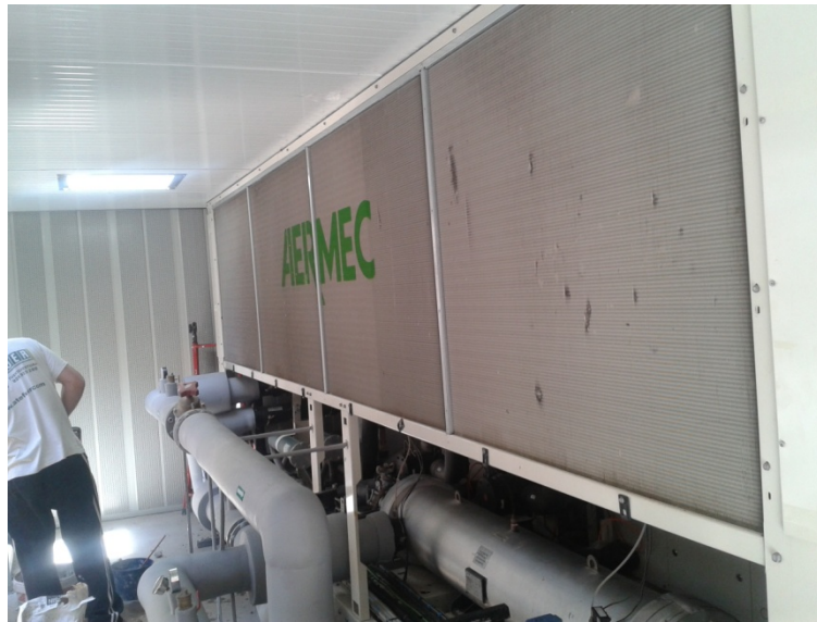
Enfriadora de alta eficiencia con recuperación de calor y detalle de insonorización acústica
