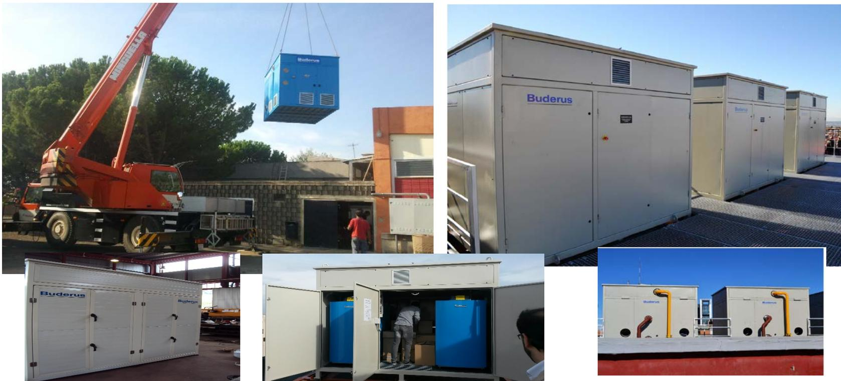
Sistemas totalmente equipados y listos para producir calor, homologados según normativa de salas de calderas.
